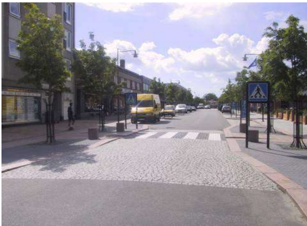
10.3.1 pav. Važiuojamosios dalies siaurinimo ir pėsčiųjų perėjos derinys Nyderlanduose [Rekomendacijos R ISEP 10]
