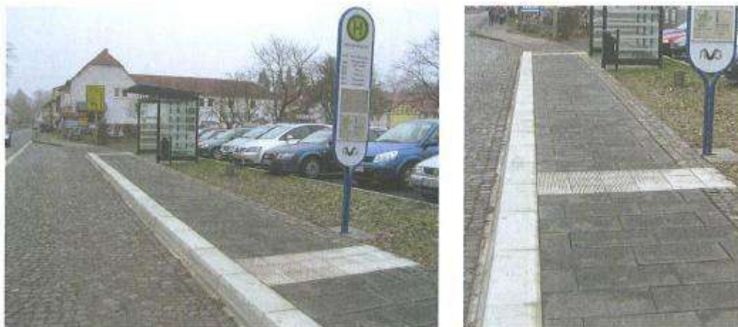
13.3.3 pav. Nurodomosios indikatorių juostos iš juostelių, įrengtos statmenai bordiūriui, autobuso sustojimo aikštelėje [Automobilių kelių ir jų elementų pritaikymo žmonėms su specialiaisiais poreikiais rekomendacijose R ŽSP 17]
