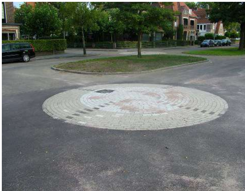
10.4.6 pav. Iškilis sferinė sankryža iš įvairių spalvų trinkelio Nyderlanduose, būtina įdiegimo sąlyga – sankryža turi būti lygiareikšmė ir taikoma tik 30 km/val. zonose [Rekomendacijos R ISEP 10]
