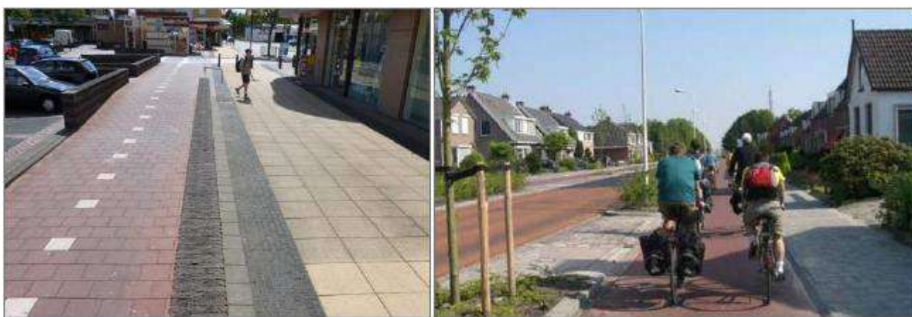
13.3.1 pav. Dviračių takų įrengimo pavyzdžiai: takas atskirtas skirtingos tekstūros juosta; dviračių ir pėsčiųjų takai įrengti skirtinguose lygiuose [Pėsčiųjų ir dviračių takų projektavimo rekomendacijos R PDTP 12]
