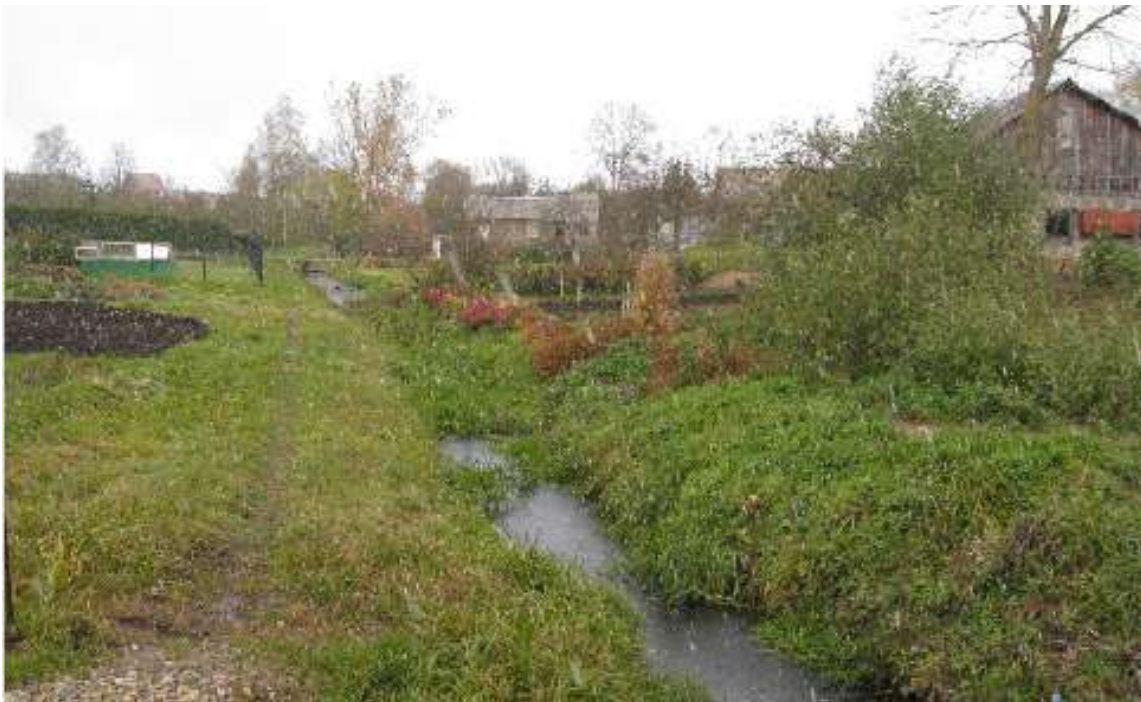
4 pav. Planuojamo pėsčiųjų tako vieta palei Vyžuonos upelį ties Birutės gatve
