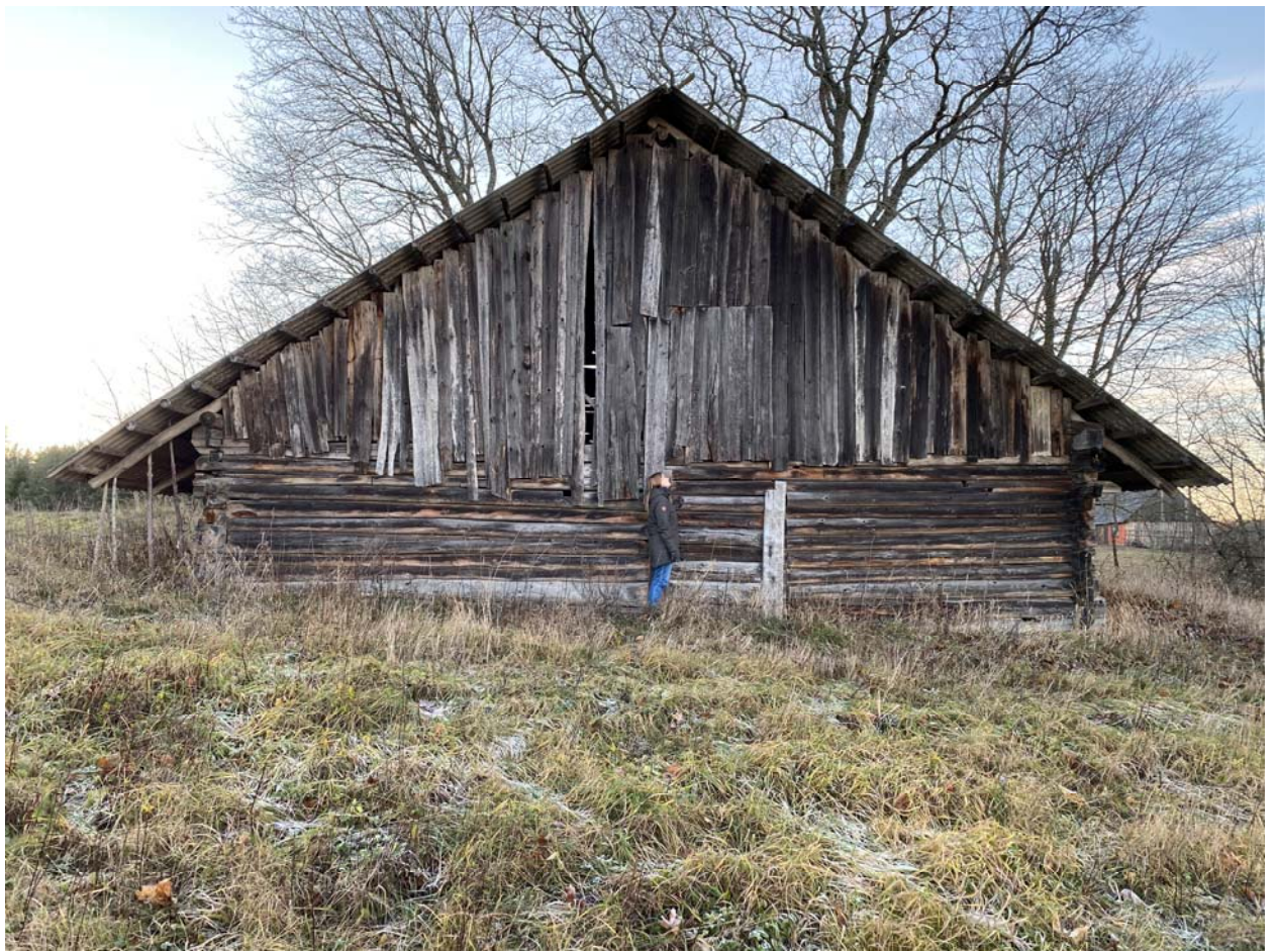
Esama daržinė – rekonstruojama
