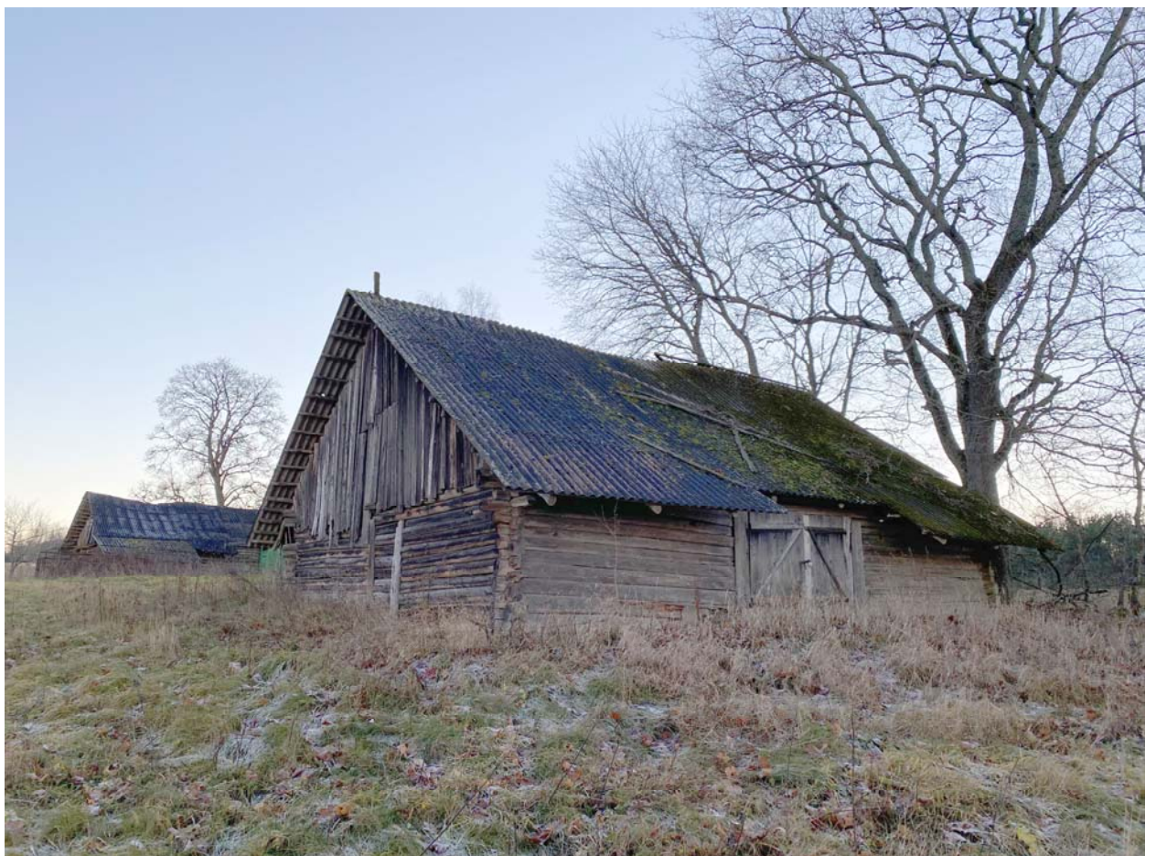
Esama daržinė – rekonstruojama
