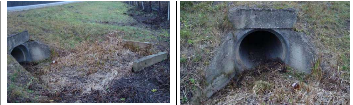
4,5. Pav. Pk 951+25 įtekėjimo antgalio baseinas, antgalis
