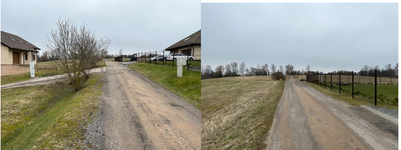
2 pav. Esamos gatvės būklės fotofiksacija
