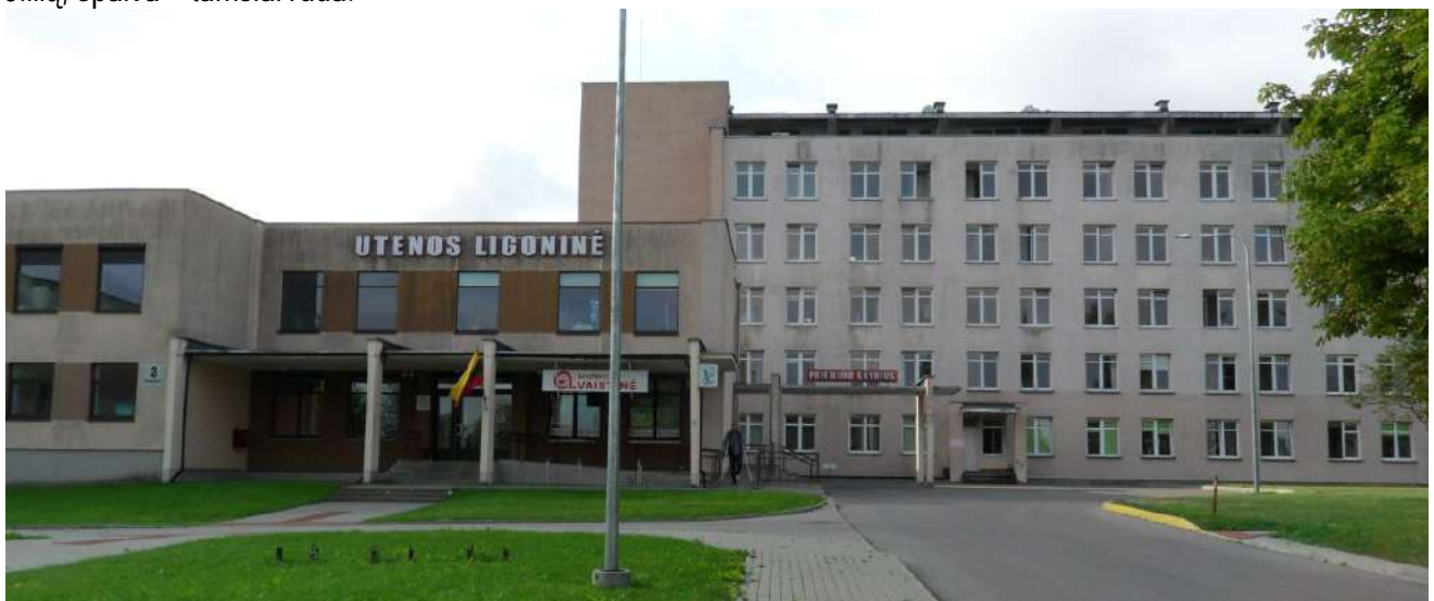
8 pav. Priėmimo skyriaus fotografacija nuo Aukštakalnio gatvės pusės
